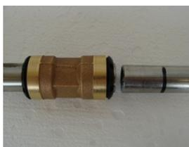
2. Muffe auf entgratetes Rohr schieben.
