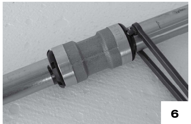
Beidseitig schwarze Kunststoffhülse mit Werkzeug anziehen.
