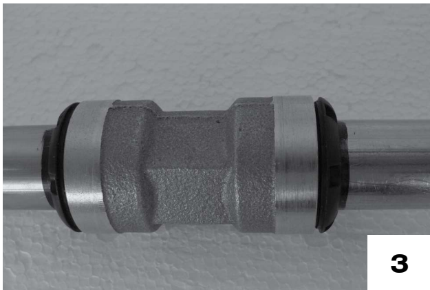
Muffe bis zur Einstecktiefe überschieben.
