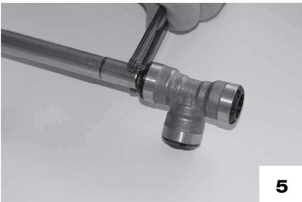
Fitting kann ab dem Rohr gezogen werden.
