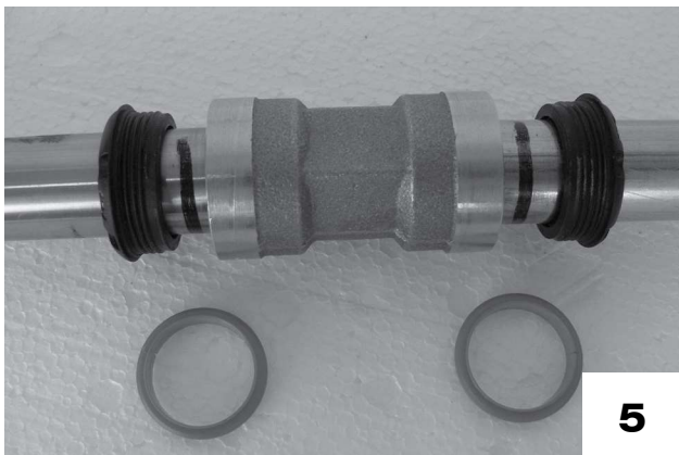
Rote Ringe entfernen. Einstecktiefe kontrollieren.
